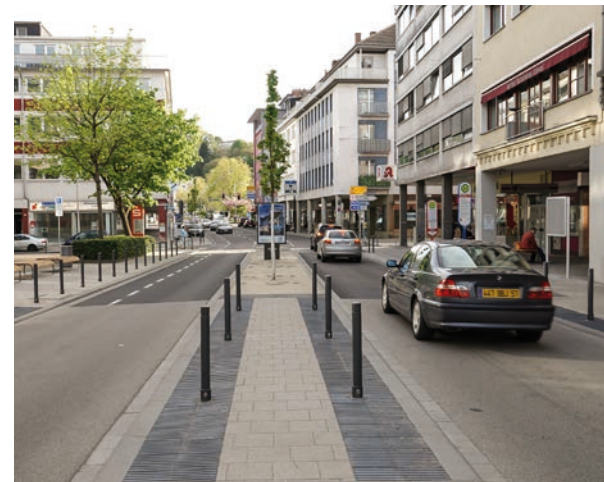
Die umgestaltete Eisenbahnstraße in Saarbrücken
